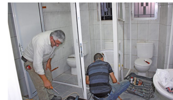
Die beiden Sanitärtrakte wurden vollständig erneuert.
